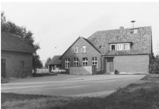
Die Tage der kleinen Landschulen waren gezählt: Die Fotografie aus dem Stadtarchiv zeigt die ehemalige Schule Österwiehe-Spitzkrug (heute Neuenkirchener Straße) ein Jahr nach ihrer Schließung, 1972.
