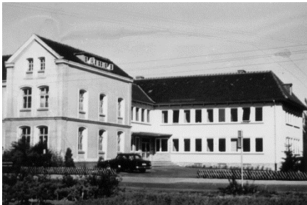
Die Fotografie aus dem Jahr 1959 zeigt links einen Teil des Altbaus des Amtshauses mit dem sich rechts anschließenden Neubau.
