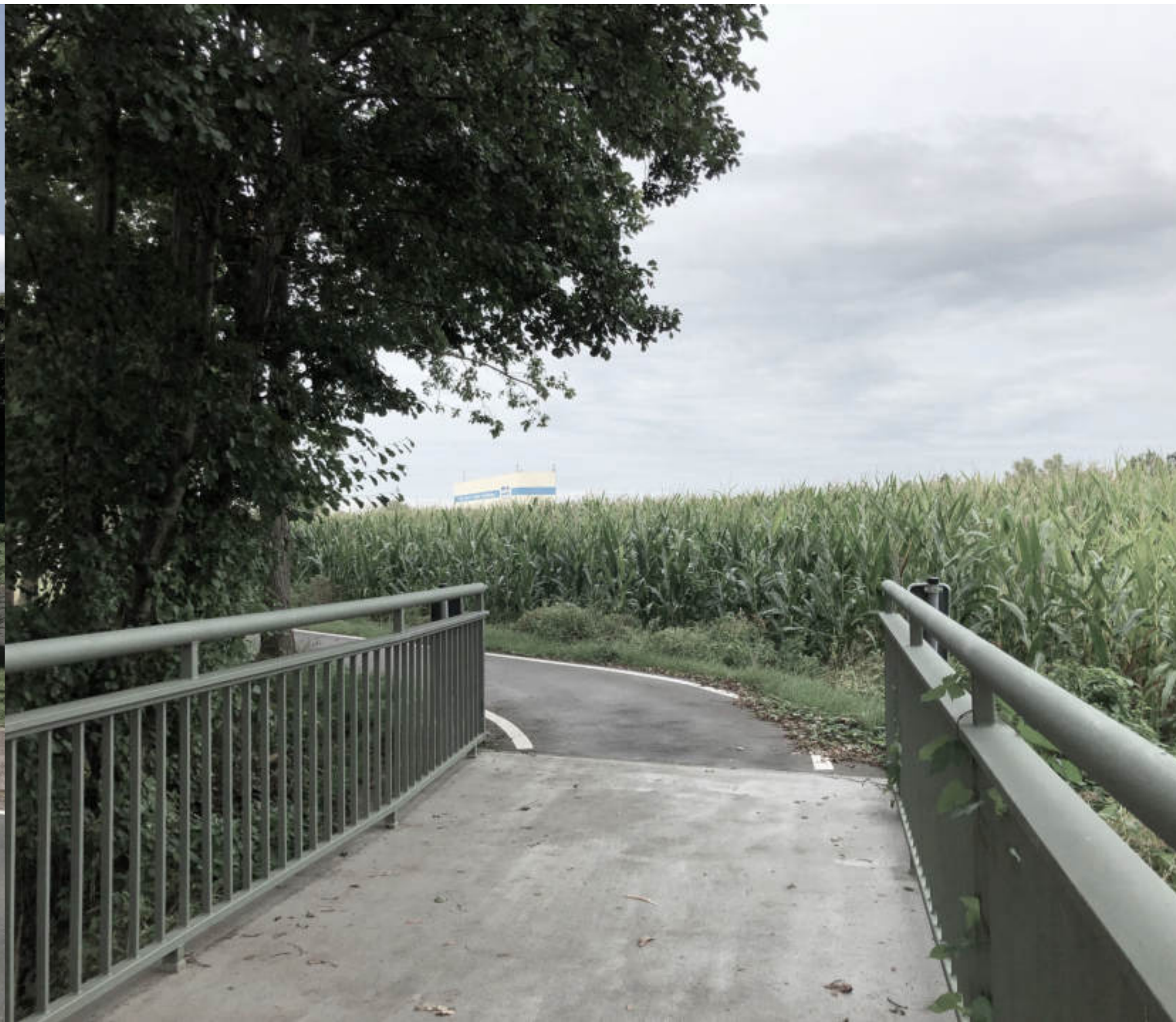
Überbrückung des Radweges
