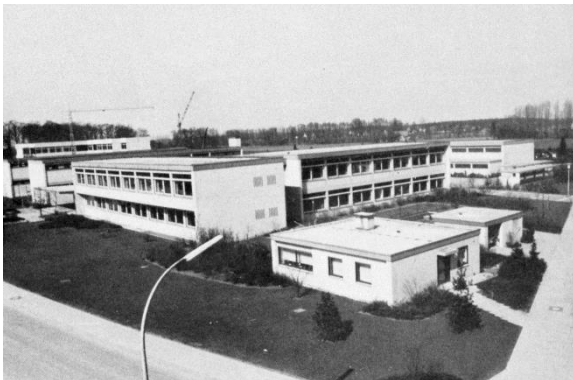
Auf der Fotografie aus dem „Adreßbuch der Gemeinde Verl 1971“ ist hinter der Realschule die Hauptschule zu erkennen, noch von Baukränen umgeben. Dort begann der „Schnatgang“.
